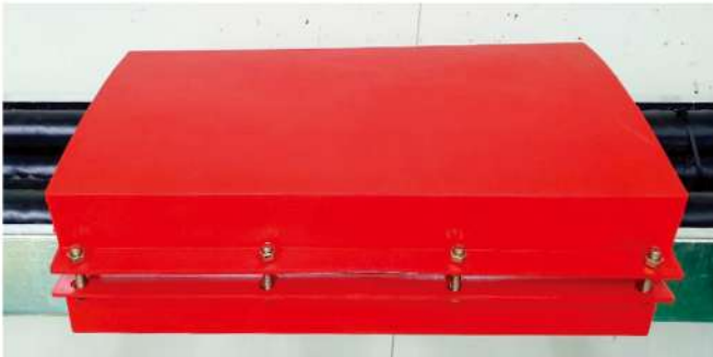
[ 트레이 300mm에 방화커버 설치 사진 ]
