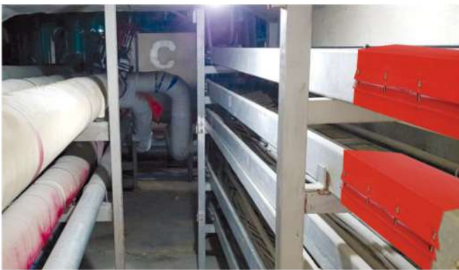
[ 트레이 300mm에 방화커버 설치 사진 ]
