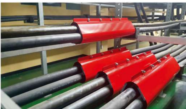
[ 송전 케이블 325sq에 방화커버 설치 사진 ]
